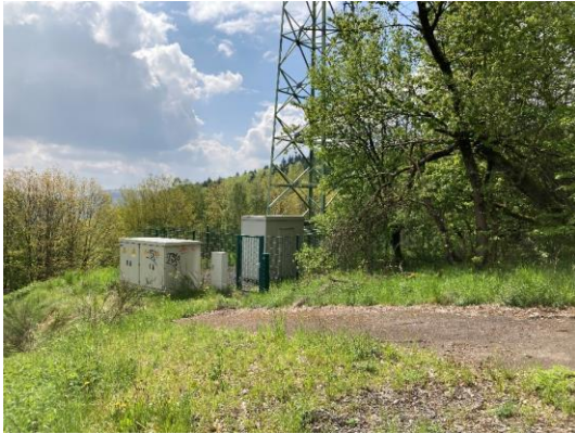
Abb. 5 Blick zum Funkmast mit Nebenanlagen und teilversiegelten Flächen.
