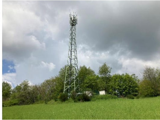
Abb. 6 Böschung zum Funkmast mit Ginster sowie Gehölzbestand zur Straße.
