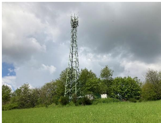
Abb. 6 Böschung zum Funkmast mit Ginster sowie Gehölzbestand zur Straße.
