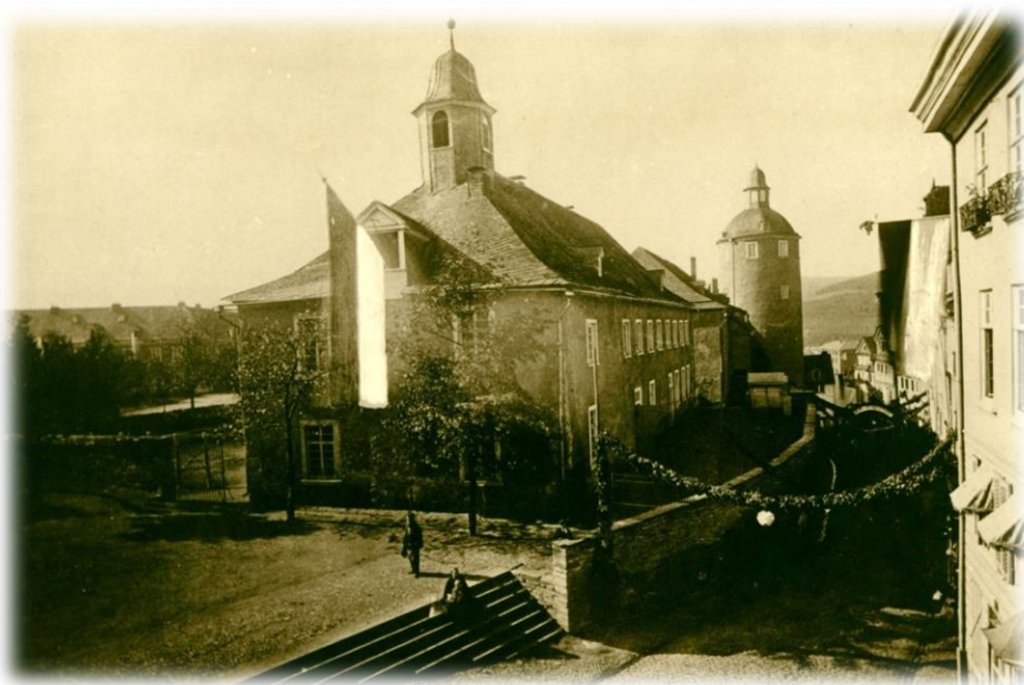
Das Marstallgebäude des Unteren Schlosses mit dem historischen Dachreiter auf einer Fotografie von 1871. Stadtarchiv Siegen, Bestand 704, Fo 5205.
