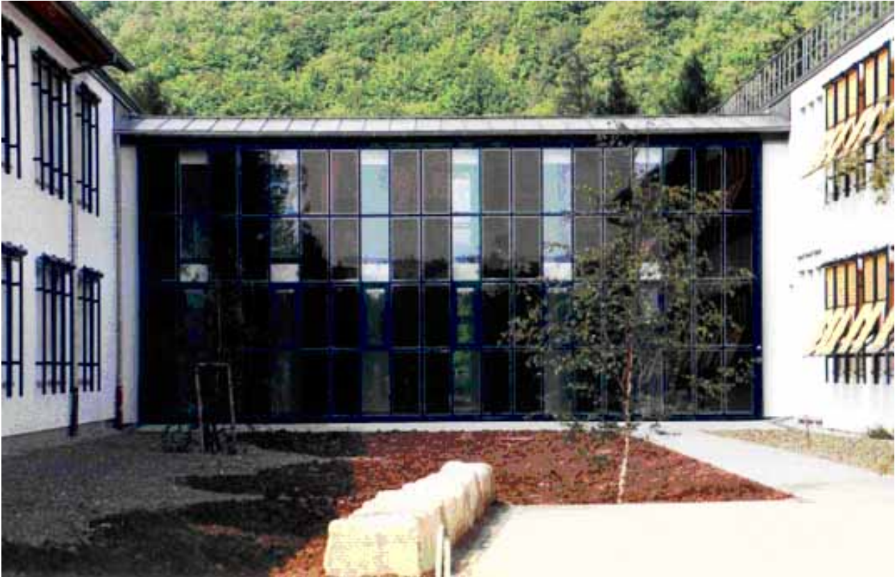
Abbildung 6-3: Solarfassade am Umwelt-Campus Birkenfeld
