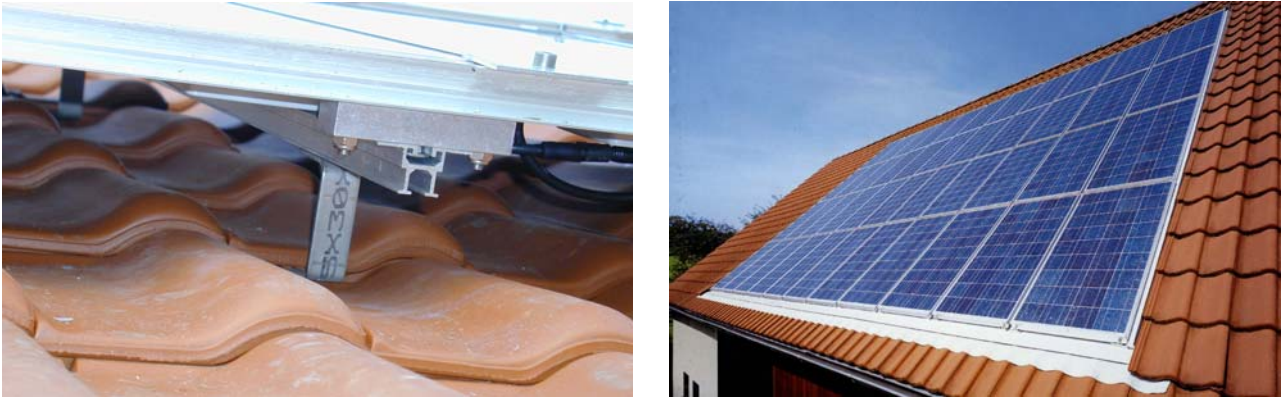
Abbildung 6-2: Auf-Dach-Montage (links) und In-Dach-Montage (rechts)
