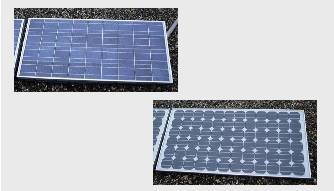
Abbildung 1-1: Polykristalline Module (oben) und monokristalline Module (unten)
