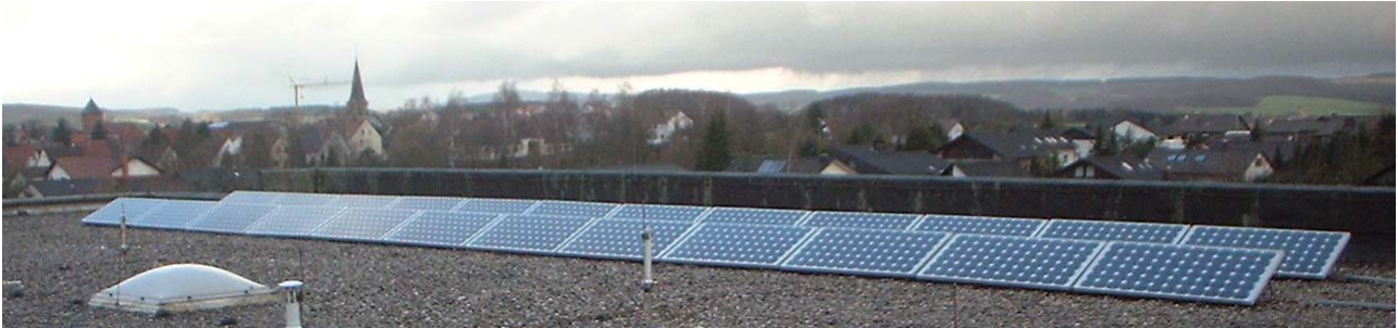
Abbildung 6-5: Flachdachmontage von Photovoltaikmodulen auf der Regionalschule Weilerbach
