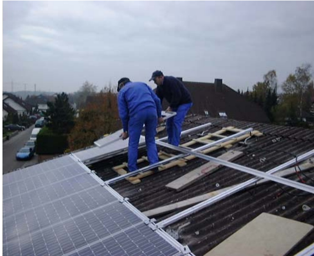
Abbildung 6-1: Montage einer Photovoltaikanlage
