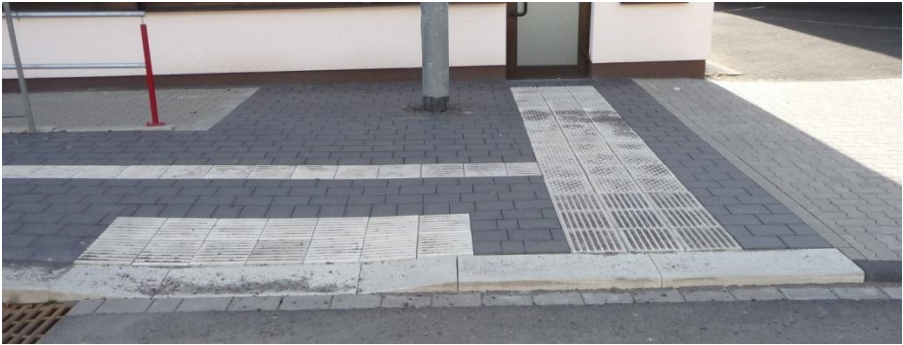
Abbildung 5: Getrennte Querung mit Nullabsenkung und 6 cm Kante
