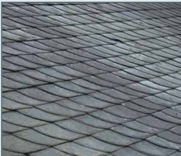
Naturschiefer | Altdeutsche Deckung | Rechtsdeckung (von links nach rechts gedeckt)
