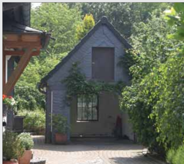
Gelungene Nebenanlage (Garage) im Siegener Stadtgebiet
