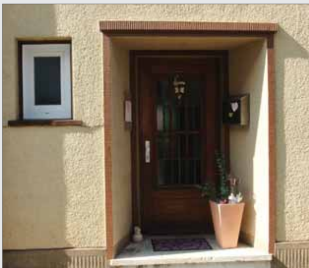
Eine deutlich hinter der Fassade zurück springende Haustür | ein weiteres Vordach ist nicht notwendig
