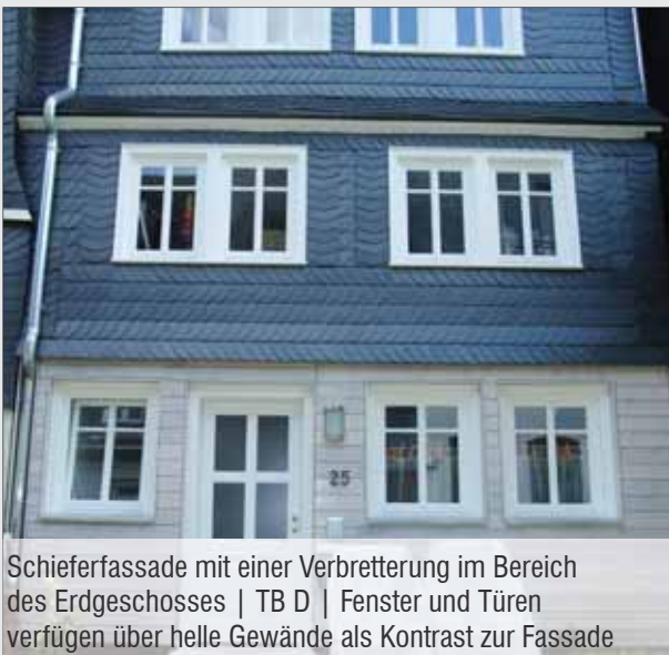
Schieferfassade TB D 1 | Verblendung der Rahmen u. Gewände durch Schiefer; der typische Fassadencharakter ist verloren 2 | Durch Fensterteilung und Gewände könnte die Fassade deutlich aufgewertet werden
