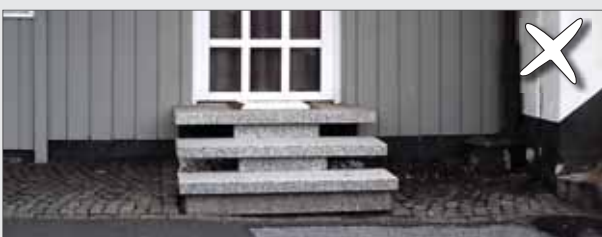
Treppenanlagen mit offenen polierten Steinplatten
