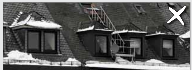
Rettungsweg über das Dach mit Geländer | TB C
