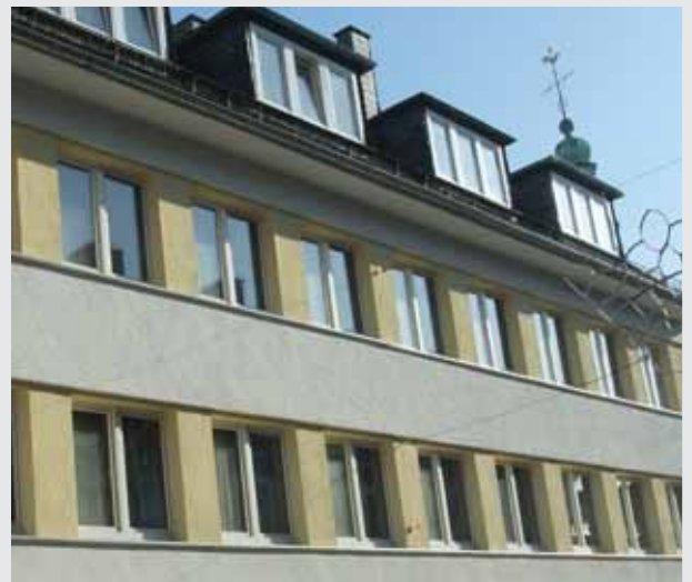
Geschäftshaus TB A | Foto der umgesetzten Fassadensanierung
