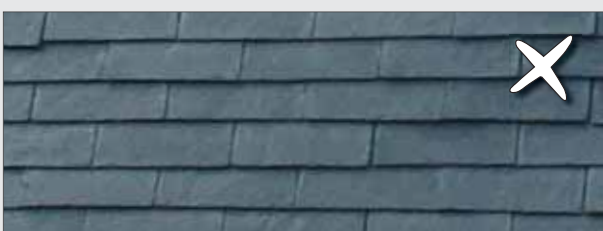
Rechteckige Platten als Schiefereindeckung
