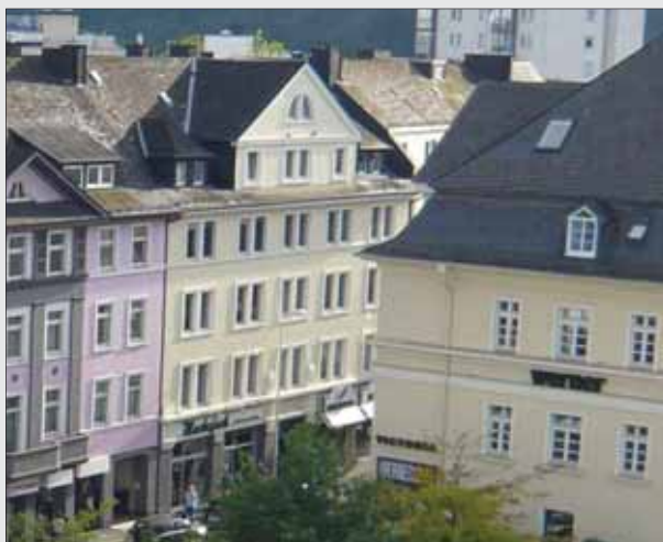
Klassisches Zwerchhaus mit durchlaufendem Dachüberstand des Hauptdaches | Giebelseite in Fassadenoptik | TB B
