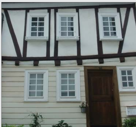
Beispiele für Fachwerkfassaden mit typischer Verbretterung im EG
