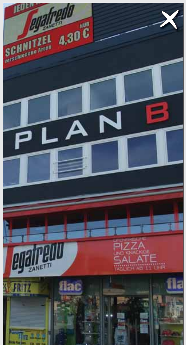
Fassade mit drei großflächigen Werbeanlagen TB B | Die ursprüngliche Fassade ist kaum noch erkennbar
